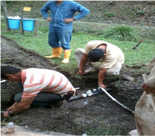
Reparación acueducto: Reparación del acueducto para aumentar la presión del agua y mantenimiento correctivo a baterías sanitarias y duchas en la Escuela Silvicultura.
